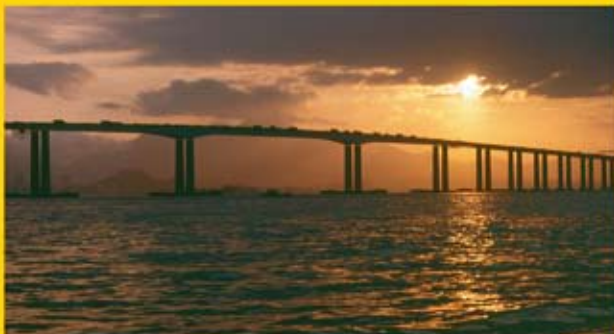
Ponte Rio-Niterói - RJ
